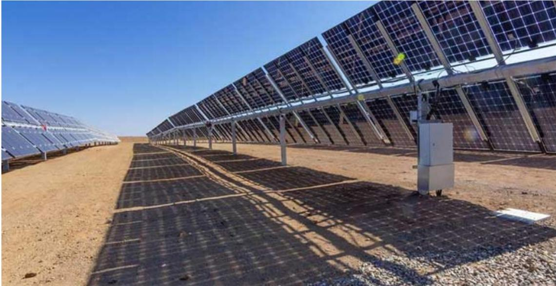
Para la aplicación de módulos bifaciales se recomienda realizar un análisis del albedo de la superficie y una proyección de la energía adicional a generar.
